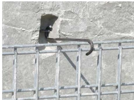
3. poser la première grille de hauteur 0.7 m en partie inférieure du mur en la maintenant à l'aide des crochets. (attention au sens des crochets, voir photo)
