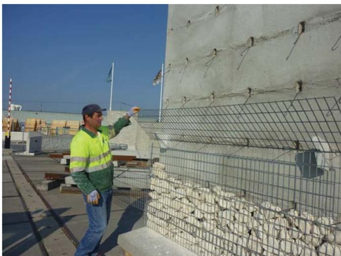
8. Relever le panneau suspendu et le maintenir à l'aide des crochets et suspendre un nouveau panneau.
