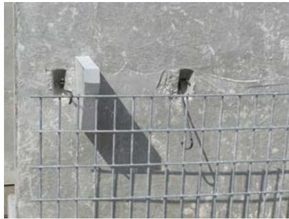
5. Mettre la deuxième grille de hauteur 0.5 m dans les crochets supérieurs du panneau inférieur avant de remplir de pierres. Assurez-vous que les fils horizontaux soient à l'extérieur.
